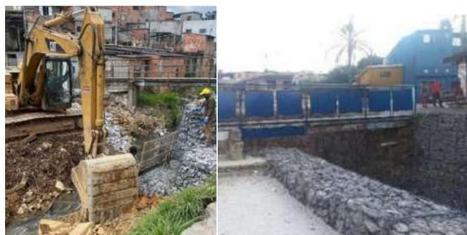
Figuras 9 e 10 - Durante e Depois Contenção de Margem SUB-CL
