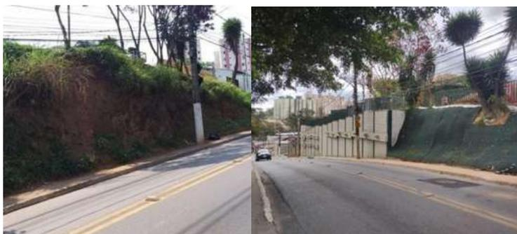
Figuras 7 e 8 - Antes e Depois Contenção de Talude Av. Alexios Jafet SUB-PJ
