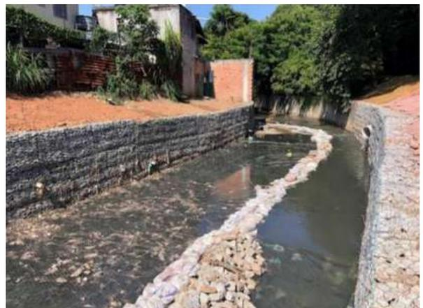
Figura 6 - Contenção Margem Córrego do Engenho - SUB-CL
